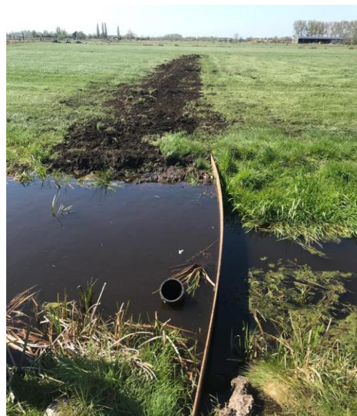
Schot geplaatst voor hoog slootpeil.
