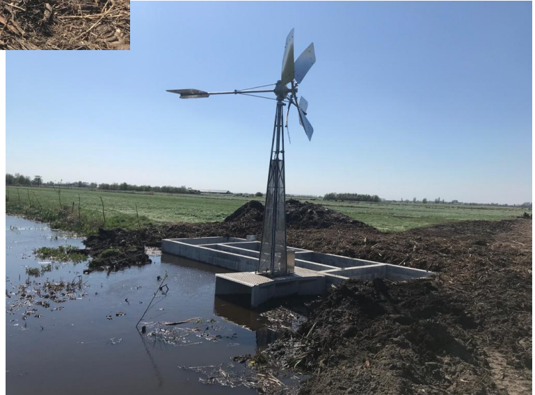
Watermolen pompt water in compartimenten voor waterinfiltratiesysteem
