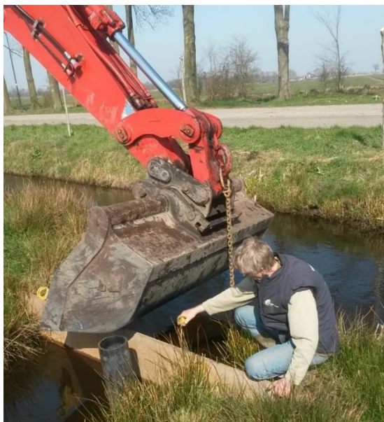
Schot plaatsen om water in sloot op hoog peil te houden
