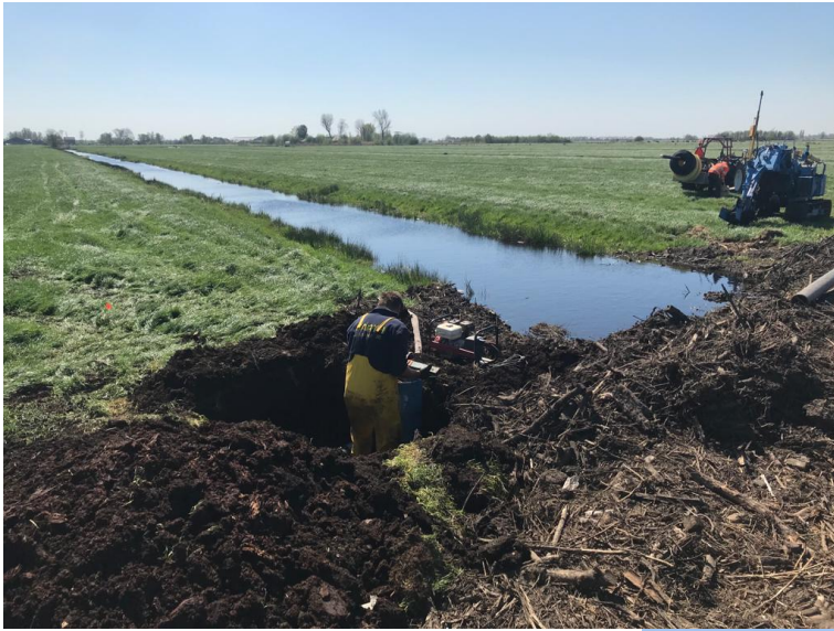
Aansluiten drains op hoofd drain
